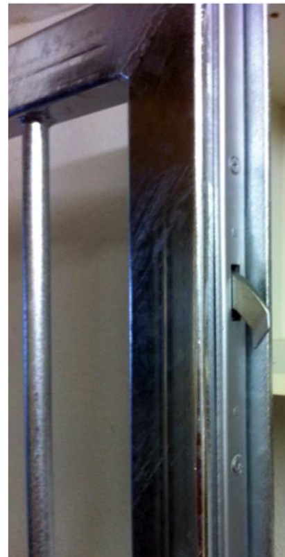
6 - fach Verriegelung, Riegel / Falle und 4 Stück dieser geschmiedeten Schwenkhaken
